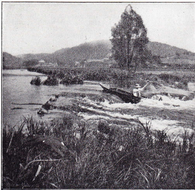
Cugnon. — Comment on passe le barrage.
